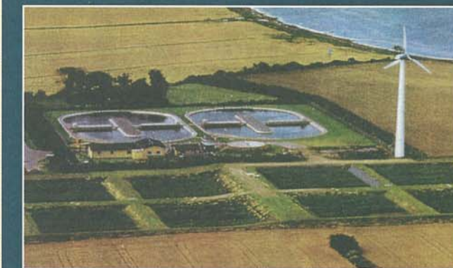
LE PHRAGMICOMPOSTAGE® PEUT TRAITER DES BOUES JUSQU'À 120 000 EH
